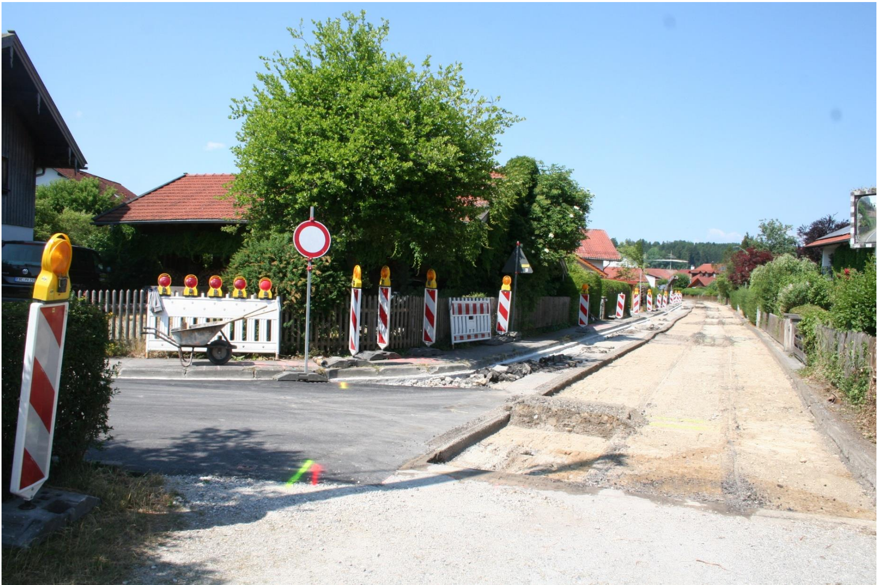
Straßensanierung am Boschertweg – Übergang vom 1. zum 2. Bauabschnitt.
