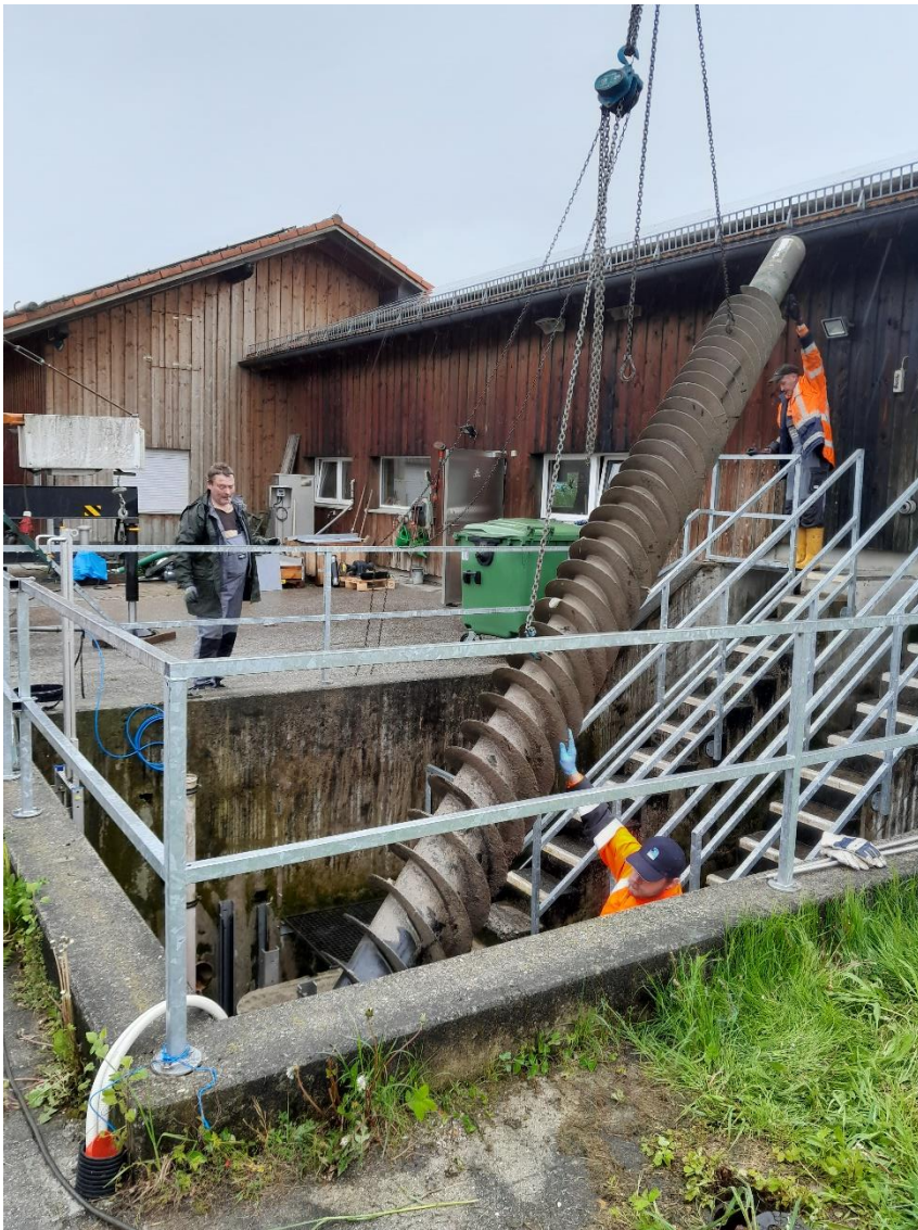
Aus- und Einbau des neuen Schneckenwerks bei der Kläranlage Aßling.
