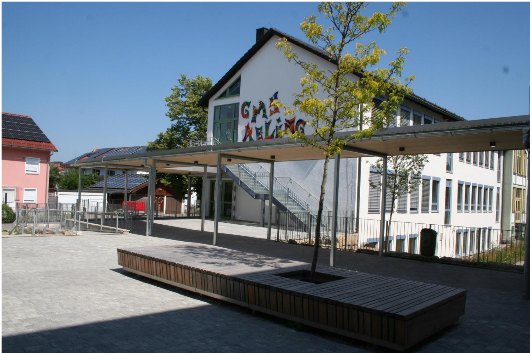
Grund- und Mittelschule Aßling in neuem Erscheinungsbild.
