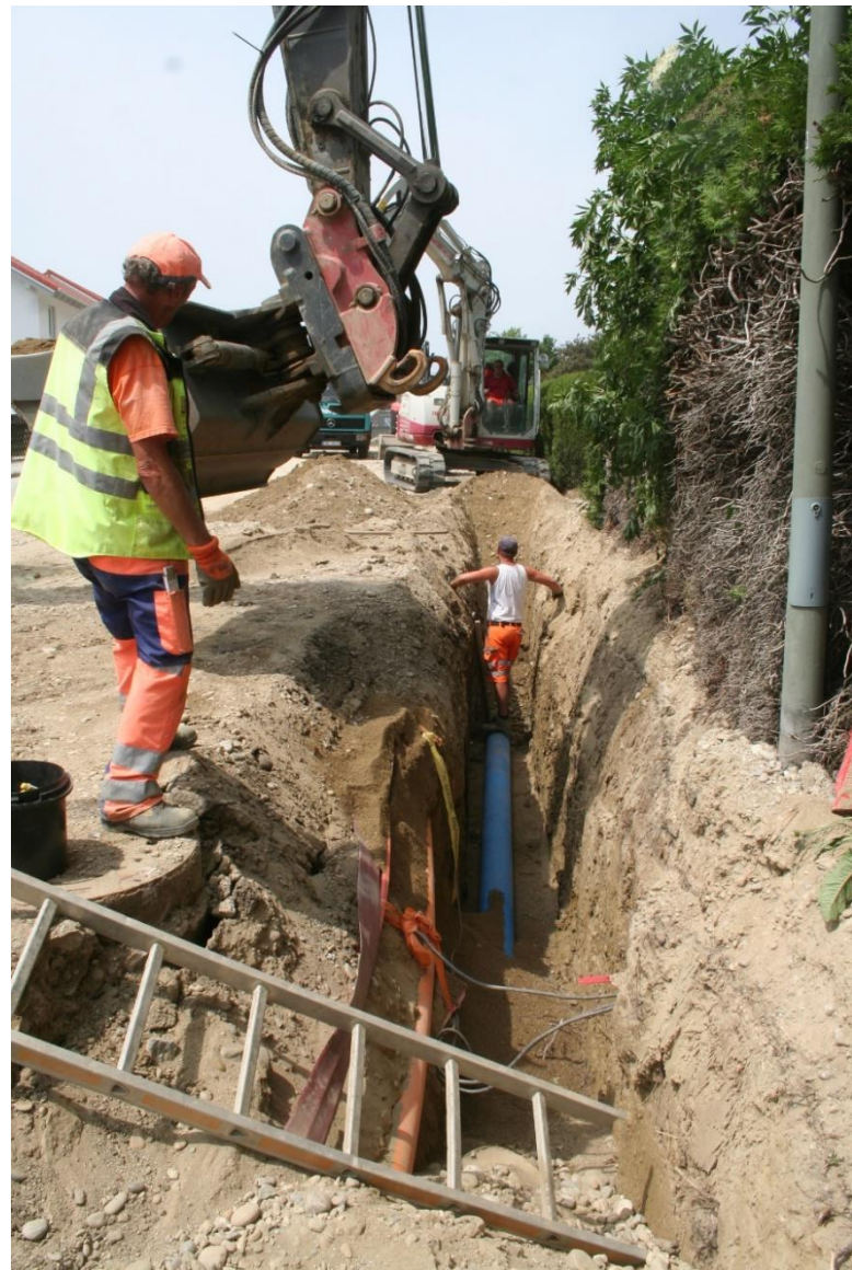
Meterweise verschwinden die blauen Regenwasserrohre in den vorbereiteten Schächten.
